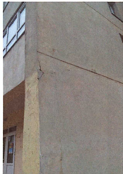
③ - Fisura la imbinarea dintre grinda si perete
