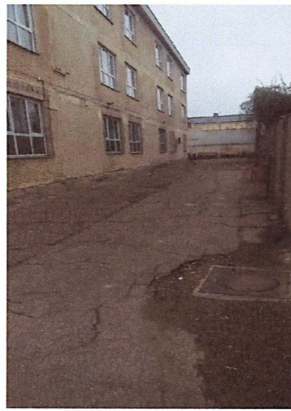
Trotuar de protectie fisurat ⑤ - Soclu deteriorat, cu umiditate
