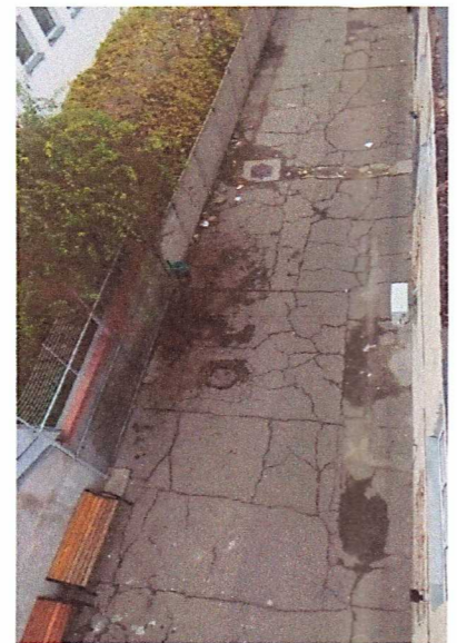
Trotuar de protectie fisurat
